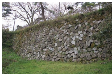
現存する石垣
